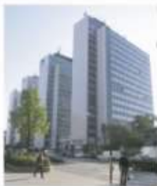
La city oggi e in costruzione. Hötorget idag och under byggandet. Foto L. af Petersens, Stadsmuseets arkiv
