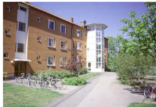
Ascensore aggiunto all'esterno della facciata
